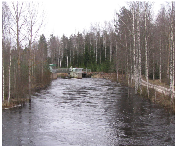
Kuva 6. Kaarenhaaran säännöstelypato Ähtävänjoella.
